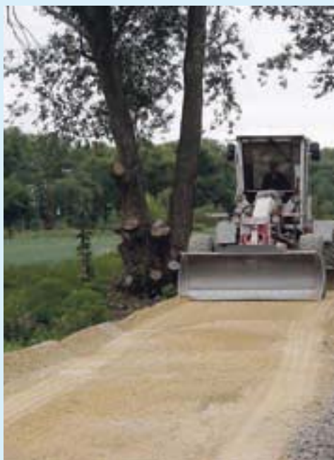
V okolí Kostelce n. L. začíná pokládka finálního povrchu.
